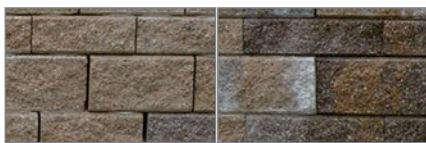
Kerítés hidrofobizált anyagból
